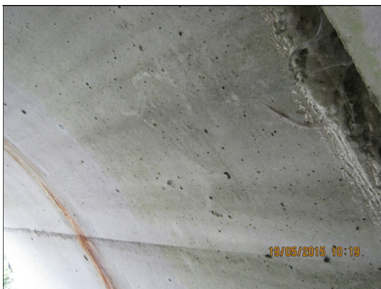
nezaspárovaná spára mezi 1. a 2. prefabrikátem zprava.
