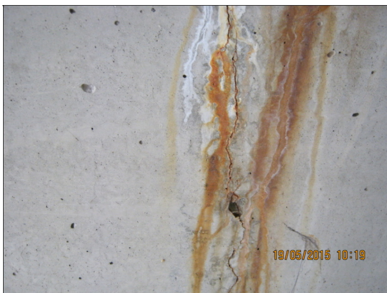
trhlina ve stěně tubusu vpravo s výronem rzi
