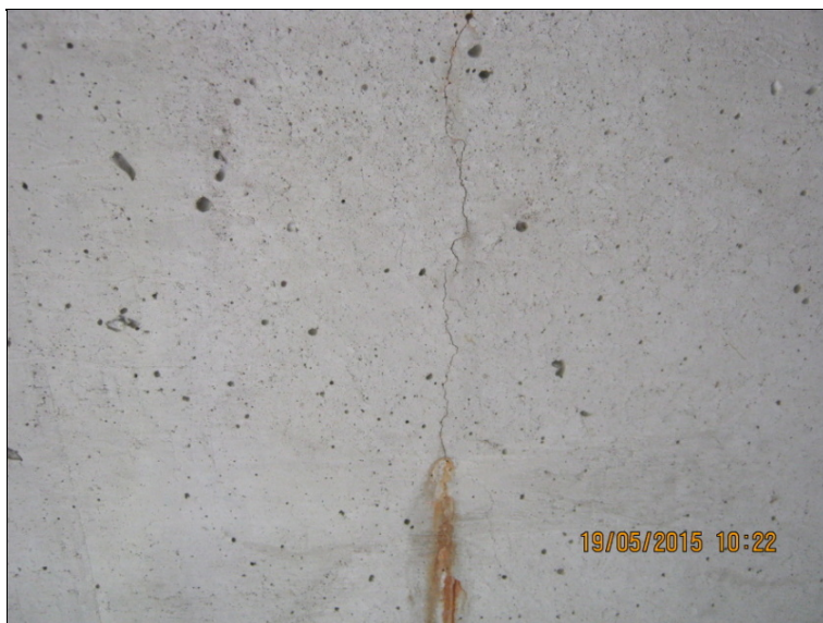
trhlina v krajním levém prefabrikátu
