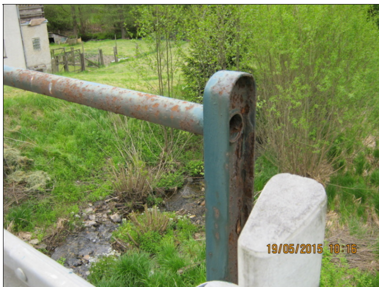
koroze madla zábradlí
