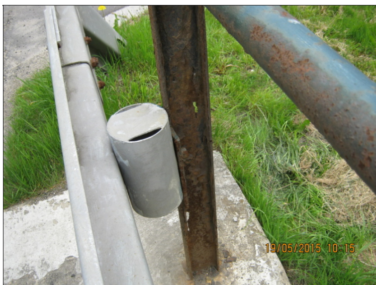
prohnilá stěna sloupku svodidla
