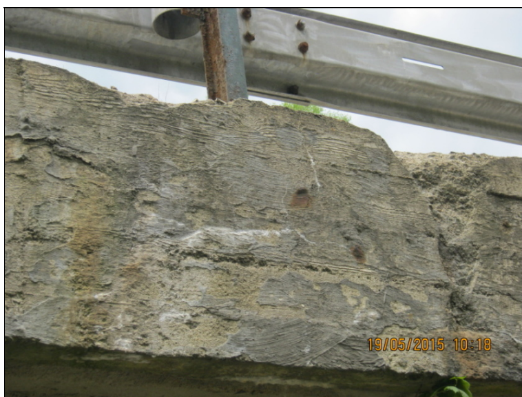
degradace betonu římsy vpravo
