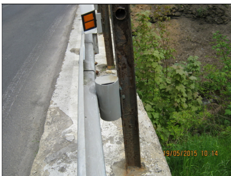
koroze sloupků svodidla, degradovaný beton povrchu římsy vpravo
