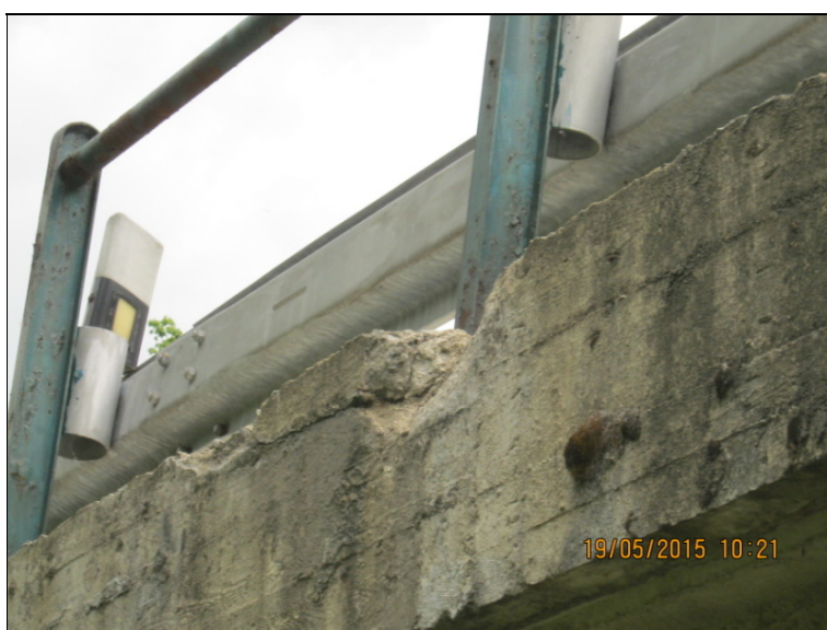
degradace betonu římsy vlevo
