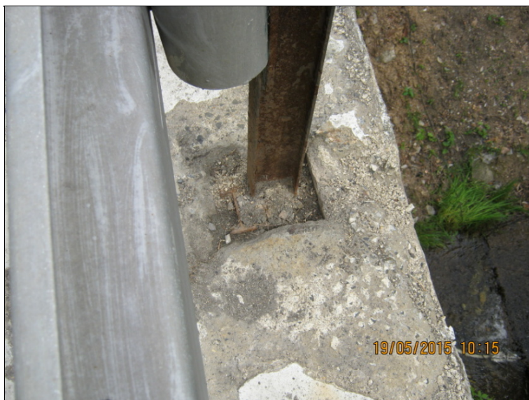
degradace betonu na pravé římse včetně zálivek kotvení svodidla
