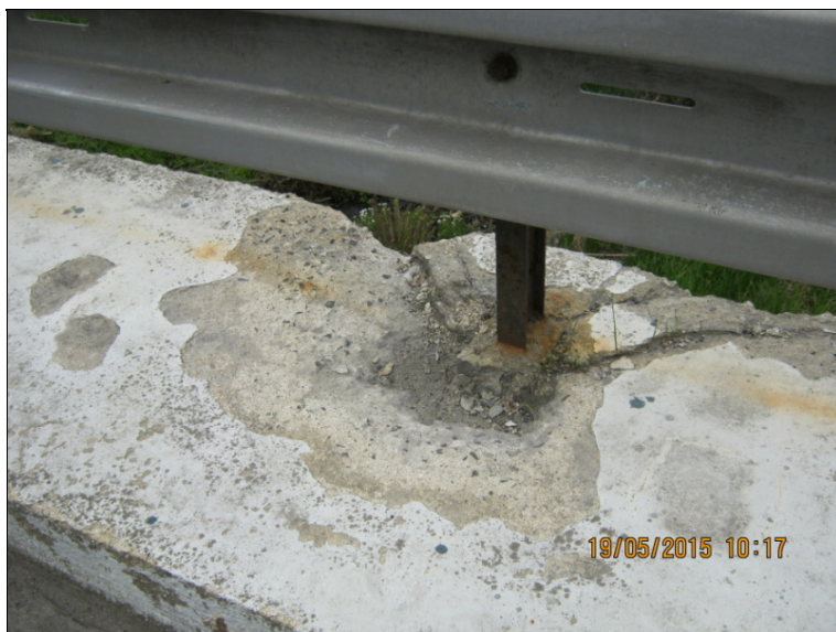
degradace betonu římsy vlevo
